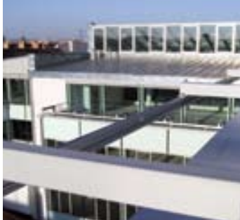
Monorail fixé sur consoles.
