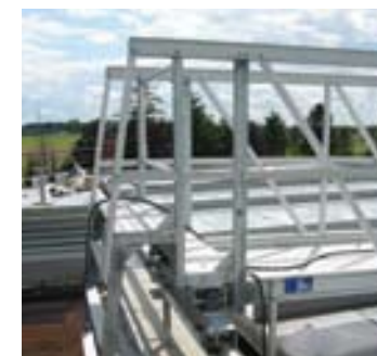
Passerelle à translation motorisée.
