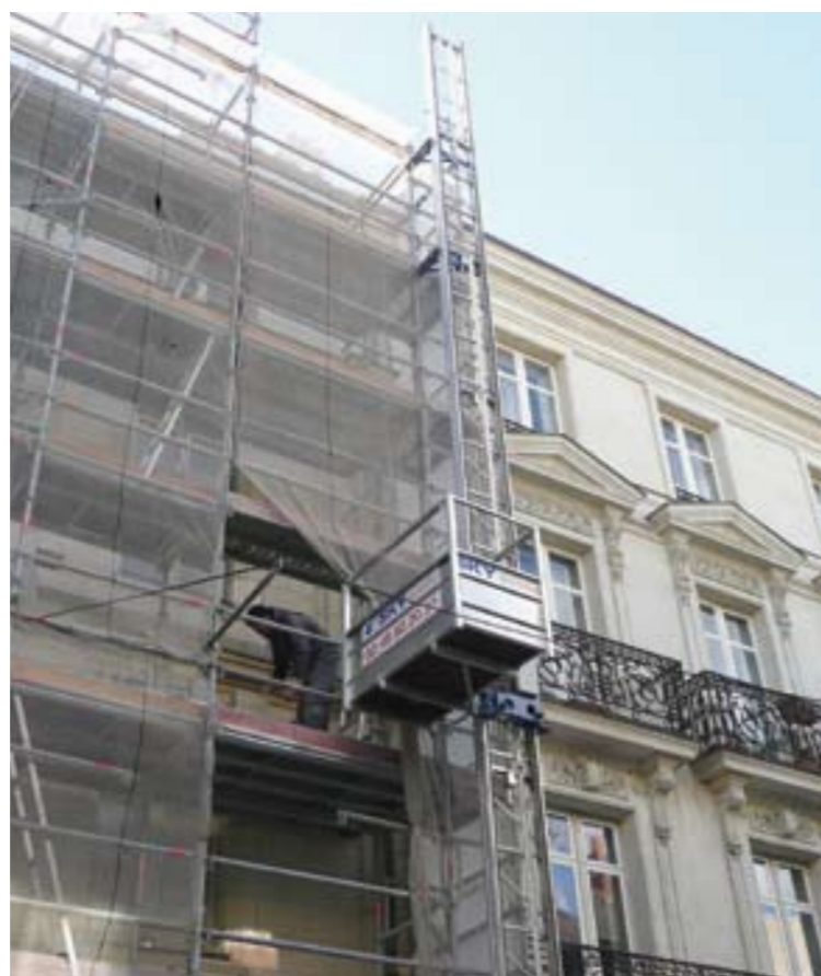
Monte-matériaux - charge utile 200 kg à caisse pivotante.
