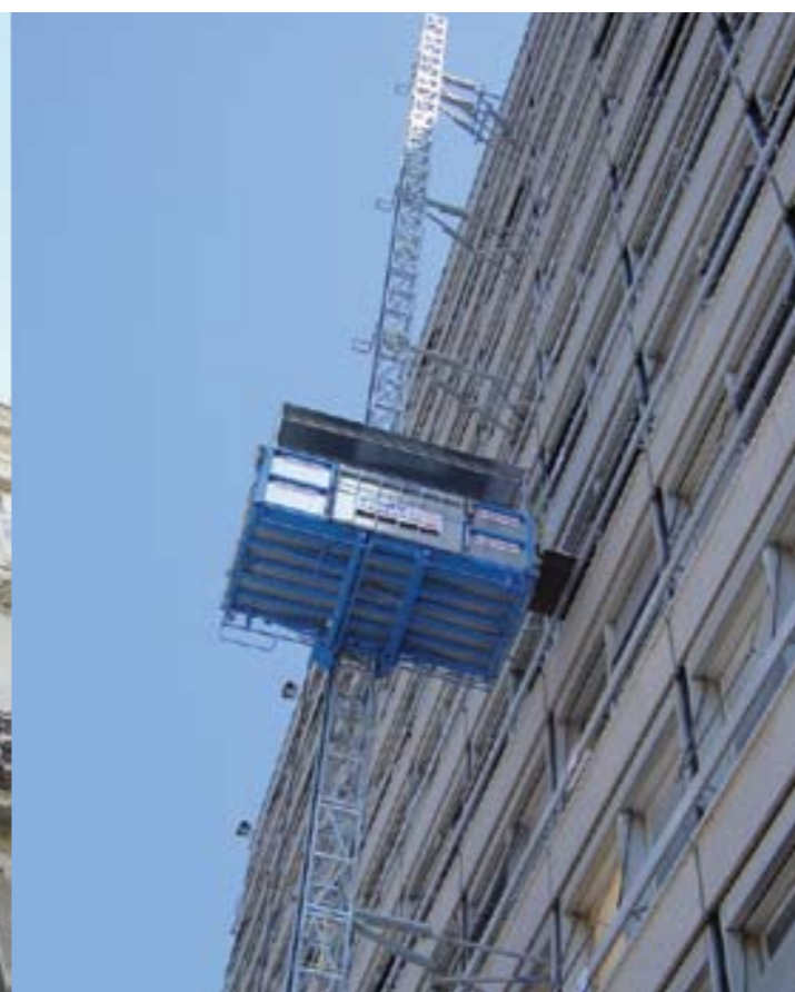
Plateforme de transport mono-mât - charge utile 1500 kg - chargement sur 2 côtés.
