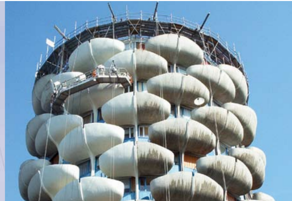
Plateforme arrondie à 2 treuils.
