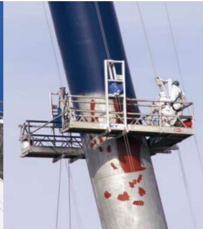
Plateforme d'angle sur une grue portuaire.
