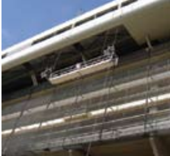
Plateforme suspendue à déport.
