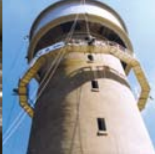
Plateforme circulaire à 4 ou 6 treuils..
