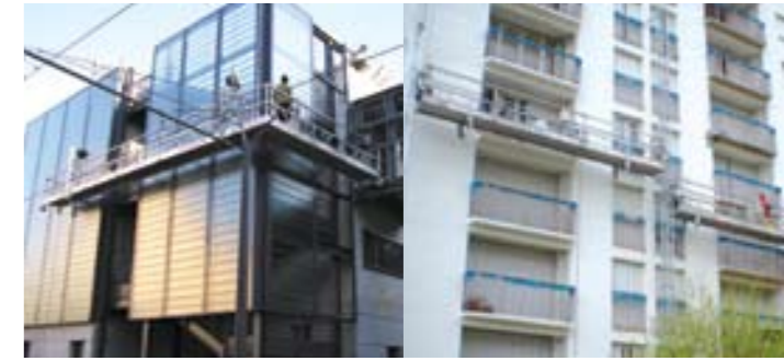
Plateforme à angle droit à 3 treuils.
